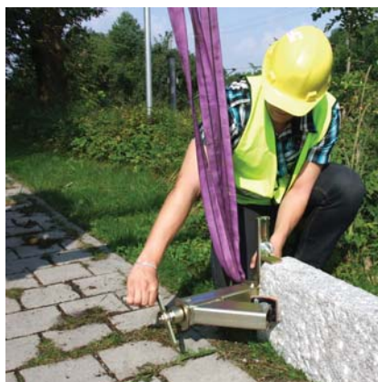
Mittels Schlaufe wird der Stelensetzer an ein Trägergerät angehängt
