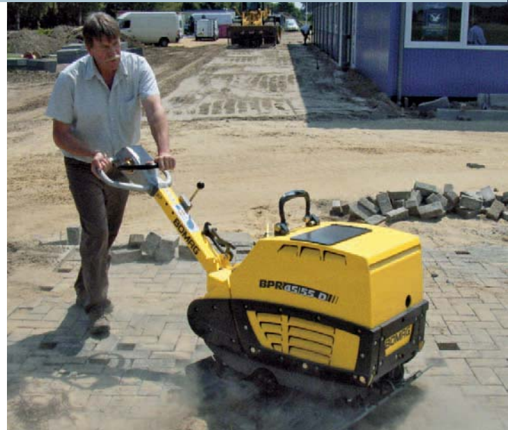
Mit Kunststoffmatte (optional) besonders gut geeignet für den Pflasterbau.
