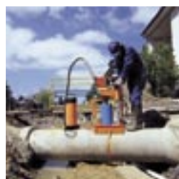
Befestigung mit Spannband.
