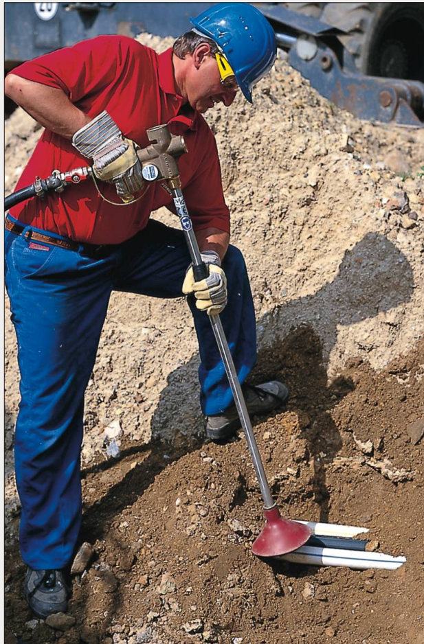
Versorgungsleitungen freilegen
