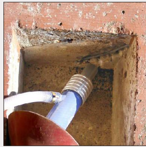
Beton-Bewehrung sandstrahlen
