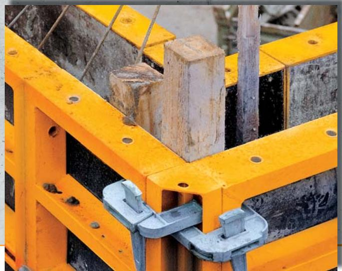
Zur Verbindung der Elemente untereinander reichen zwei Schnellspannklammern. Die Festigkeit der Klammern ist so hoch, dass mit nur zwei Verbindungsstellen pro Element selbst große Flächen mit Kran versetzt werden können.
