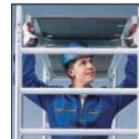
Die rutschsicher profilierten Arbeitsböden werden schnell von einer Person eingebaut: auflegen - andrücken - die Klauen rasten ein und arretieren abhubsicher.
